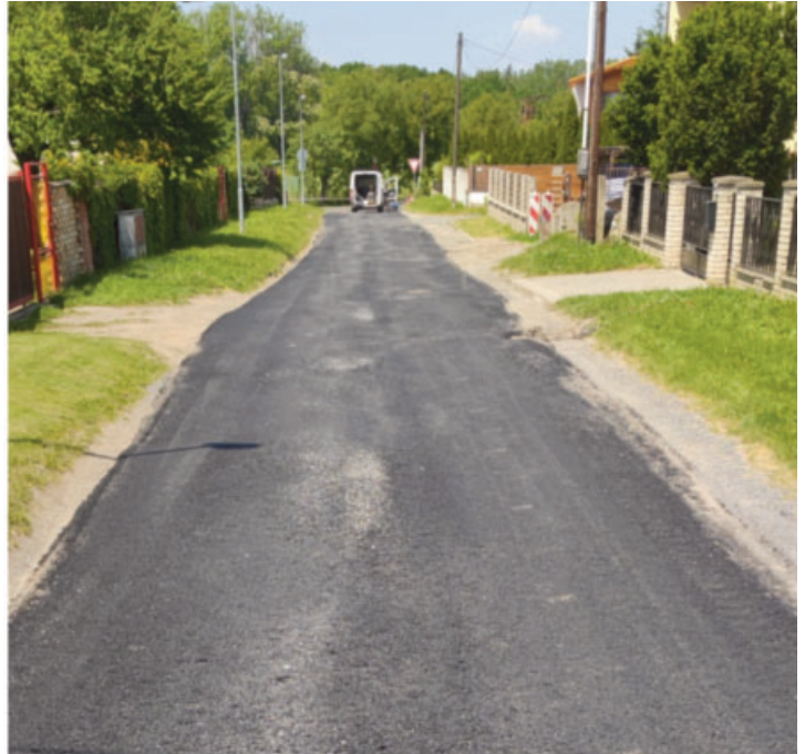
Obr. 25: Oprava povrchu Vodorovné dopravní značení
