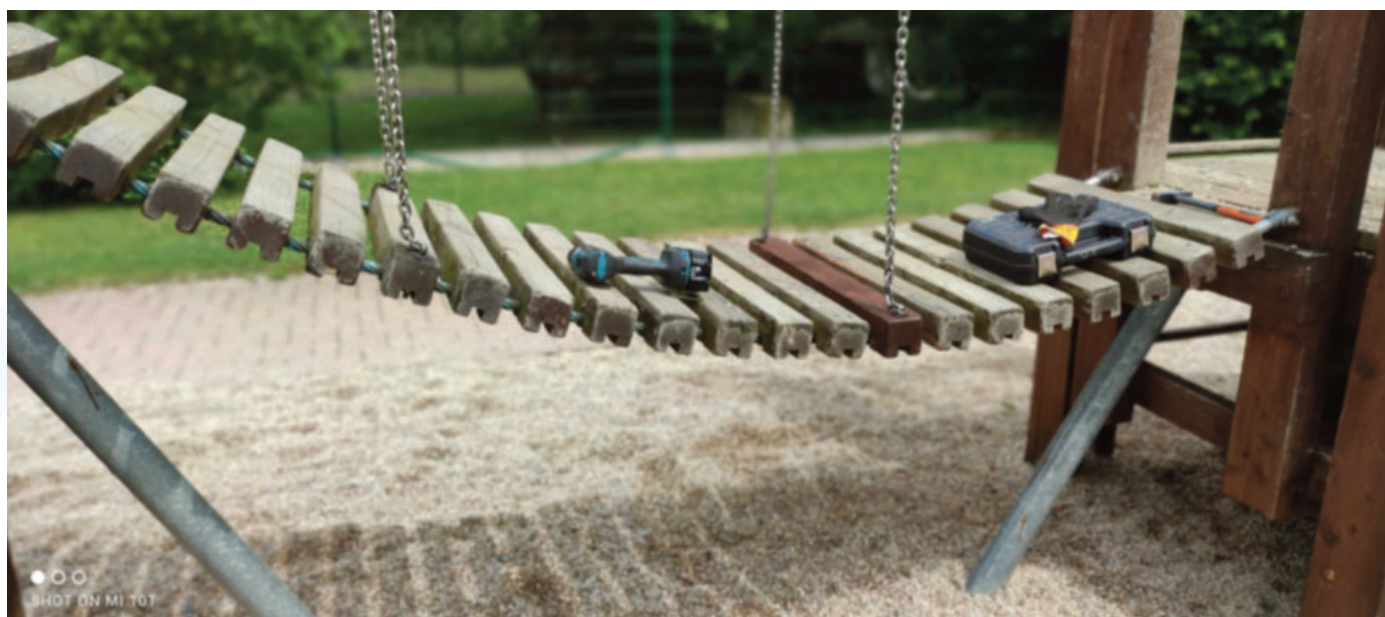
Obr. 17: Oprava mostku na dětském hřišti
