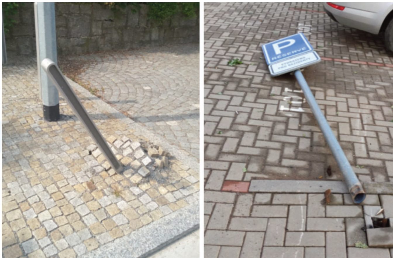
Obr. 22-23: Poničené dopravní značení: sloupek a dopravní značka
